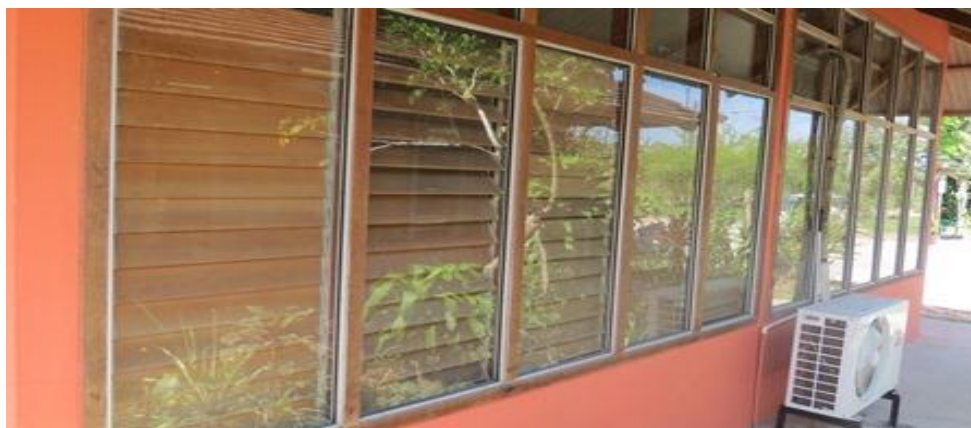
Foto 1. Adecuación de ventanería. Sept de 2015
